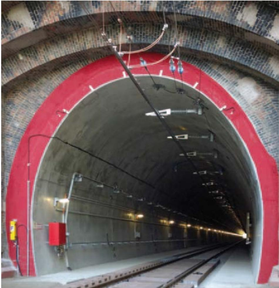
**Abbildung 8: Deckenstromschiene**
